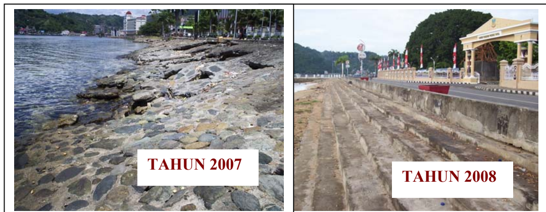
Gambar 6.7: Pengamanan pantai di teluk Humbolt sepanjang pantai Dok II
