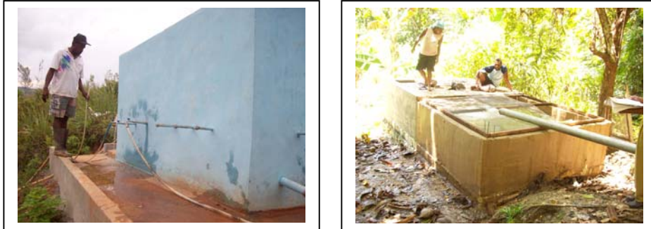
Gambar 8.7: Pembangunan sarana air bersih bagi masyarakat
